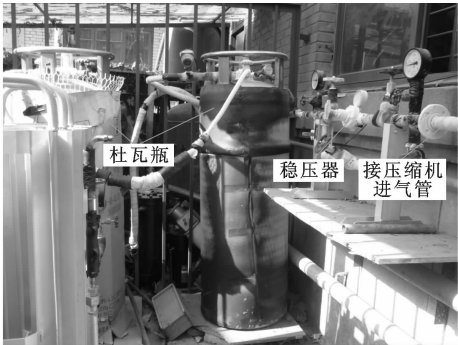
(a)液氮气化及稳压装置
